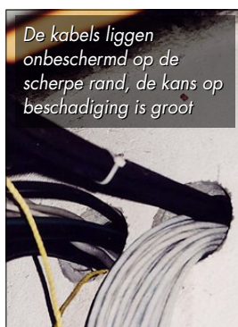
Te veel kabels door een te kleine doorvoering
