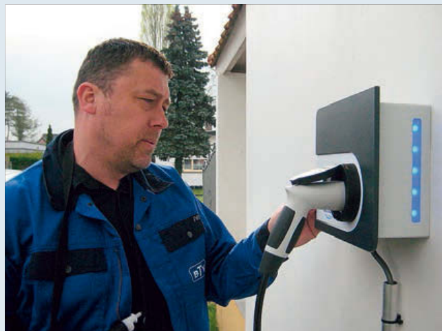
Het bijplaatsen van een kring kan beschouwd worden als een belangrijke uitbreiding van een huishoudelijke installatie
