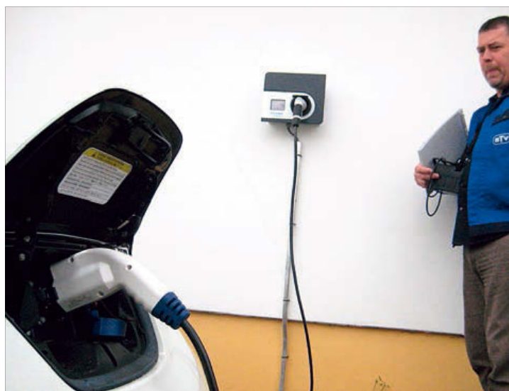
Een laadpaal voor eigen, particulier gebruik heeft een andere laadcyclus dan die voor openbaar gebruik.
