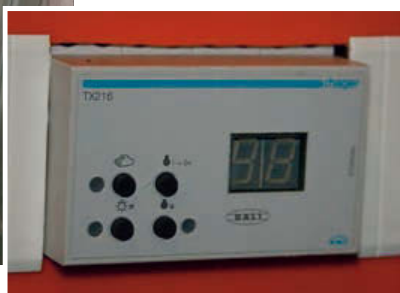
De volledige lichtinstallatie wordt aangestuurd met een DALI-controller
