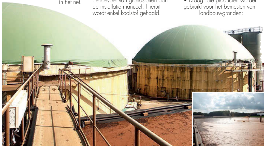
Opslagsilo's voor het biogas. De natte afvalstoffen worden opgevangen in een immense bak (inzet). Later zullen ze worden weggevoerd naar onder meer wijnboeren in Frankrijk waar de meststoffen populair zijn
