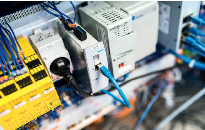
Klein en efficiënt: de CMMO-sturing stuurt de elektrische cilinder EPCO via een IO-Link.
