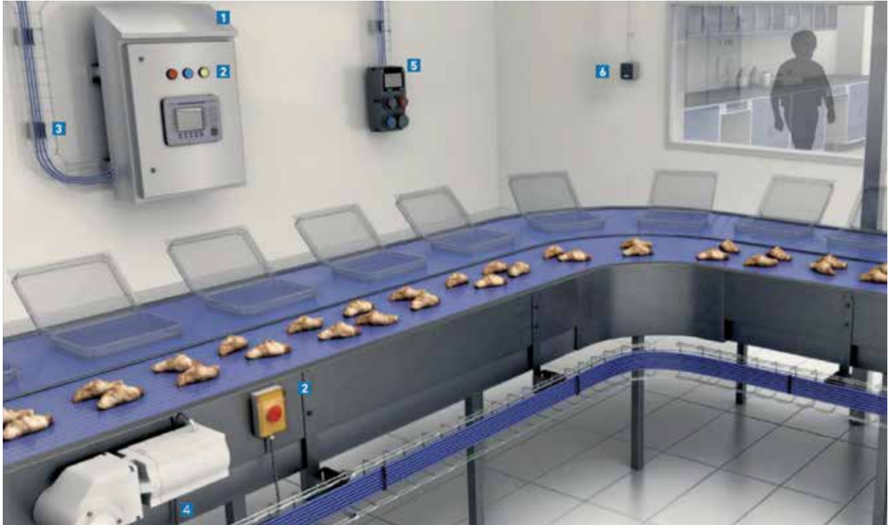
Enkele aandachtspunten bij installatie in de voedingsnijverheid: verdeelkasten met hellend dak (1), drukknoppen en wartels met afgeronde vormen (2), rvs kabelgoten (3), korte kabellengtes (4), aangepaste contactdozen (5) en schakelaars (6).
